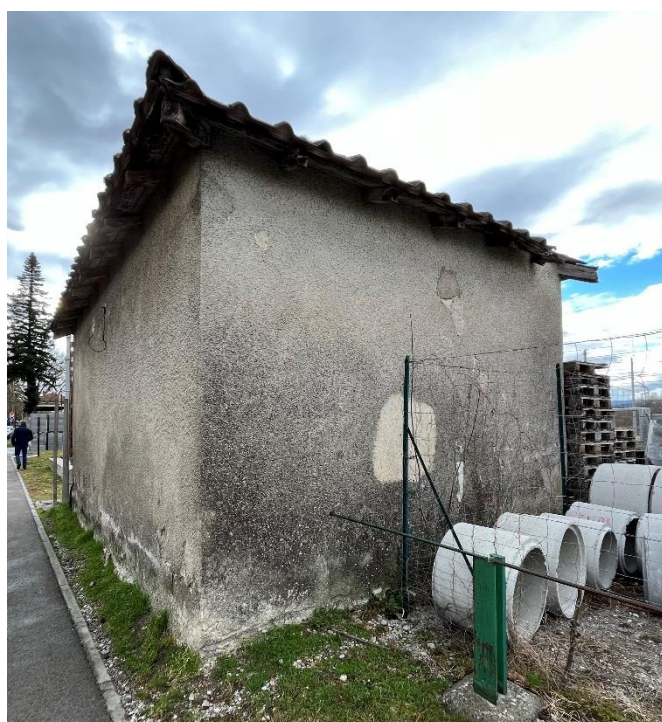
Slika 6: Manjši zapuščen objekt (cca v km 15+885)
