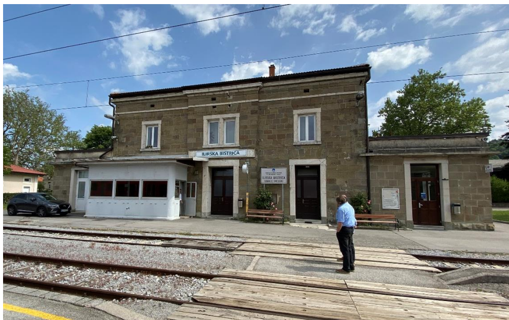
Slika 2: Postajna stavba na železniški postaji Ilirska Bistrica
